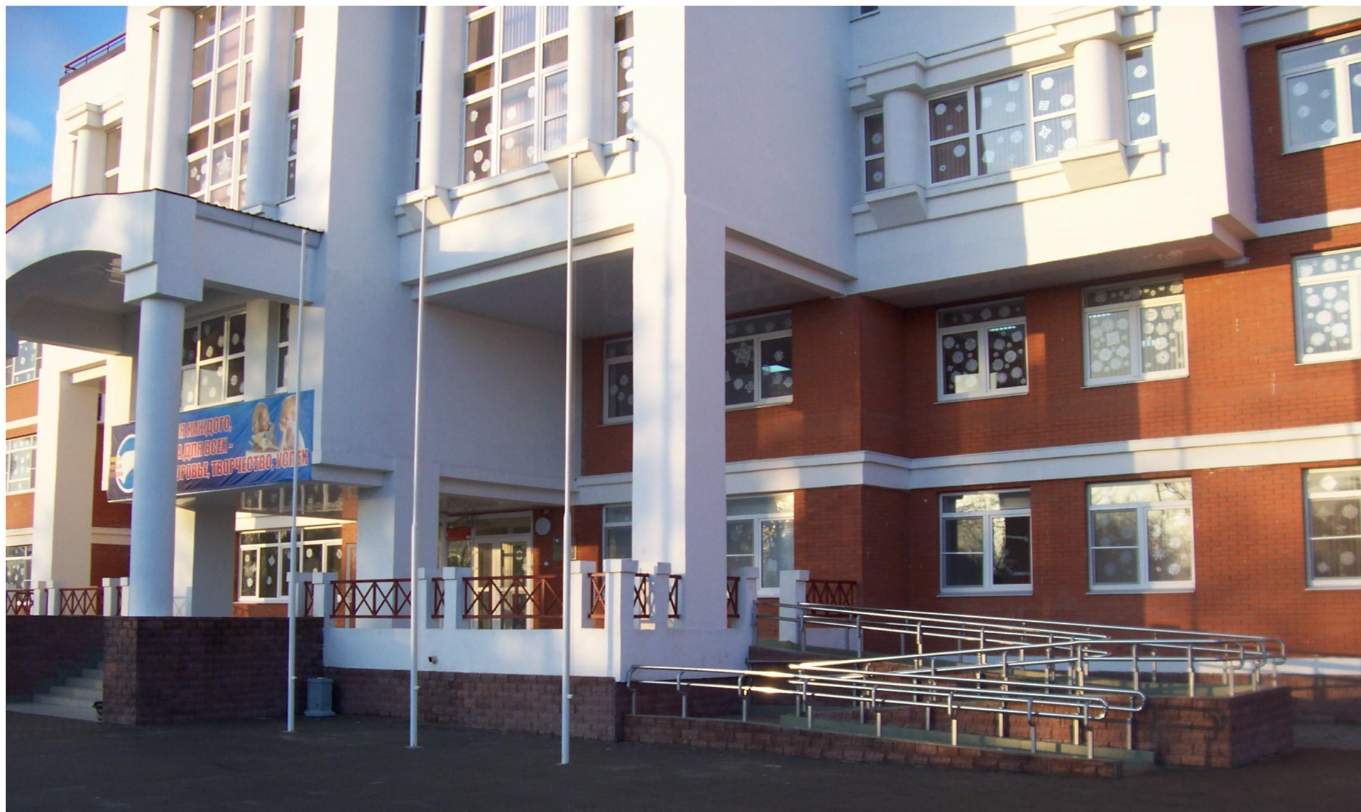
Центральный вход в школу с пандусом
